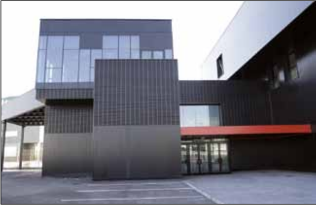
Con esta tecnología punta en lo que a eficiencia energética se refiere tiene la Fundación buenas posibilidades de ser reconocido como un de los primeros edificios EECN (Edificio de Energía Casi Nulo).
