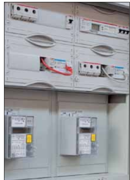
Contador inteligente para plantas fotovoltaicas y sistemas similares, incluido medición KNX secundaria.
