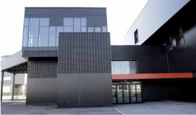
Оборудованная современными технологиями сбережение энергии, штаб-квартира Фонда имеет все шансы стать одним из первых зданий с нулевым энергетическим балансом в Испании.
