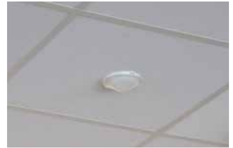
▲ L'éclairage intérieur du magasin : les détecteurs de présence au design élégant en forme de « goutte d'eau » s'intègrent parfaitement au plafond.
