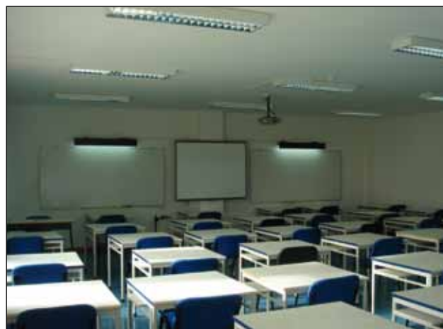
Salle de classe avec la technologie d'éclairage à économie d'énergie, protection solaire, automatisation KNX et capteurs intelligents
