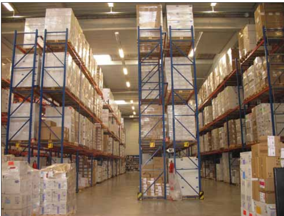
Réduction de la consommation actuelle dans l'entrepôt grâce à un contrôle automatique de l'éclairage
