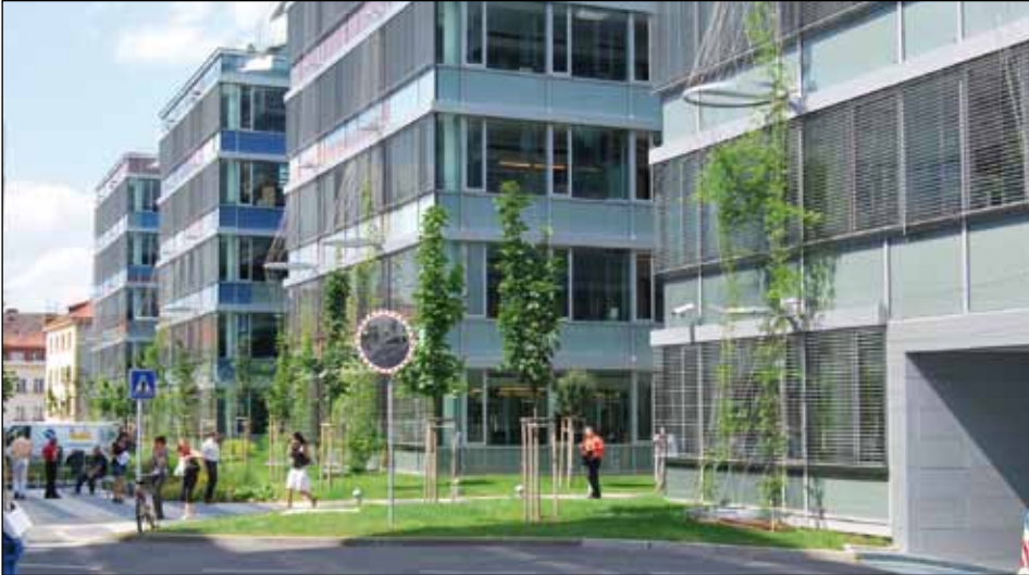
Les systèmes de protection solaire contrôlé avec KNX contribuent à améliorer considérablement le bilan énergétique
