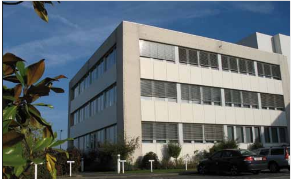
Un système protection solaire contrôlé par capteur réduit la charge de refroidissement
