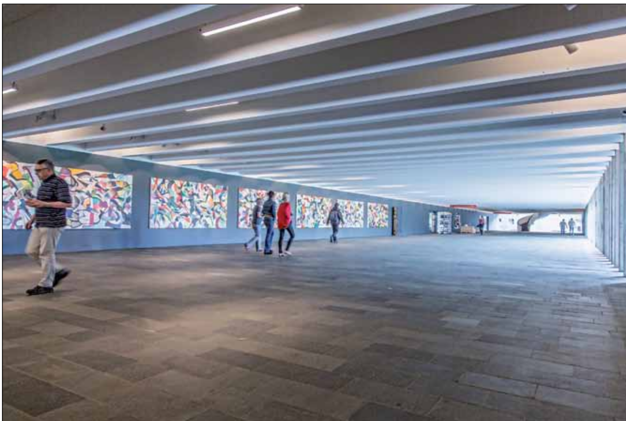
Knap 500 LED-armaturer med DALI-forkobling oplyser de store vandrehaller på Danmarks Tekniske Universitet, DTU
