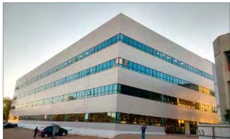
Sensoren an den Fassaden helfen, die externen Beleuchtungsniveaus zu überwachen.
