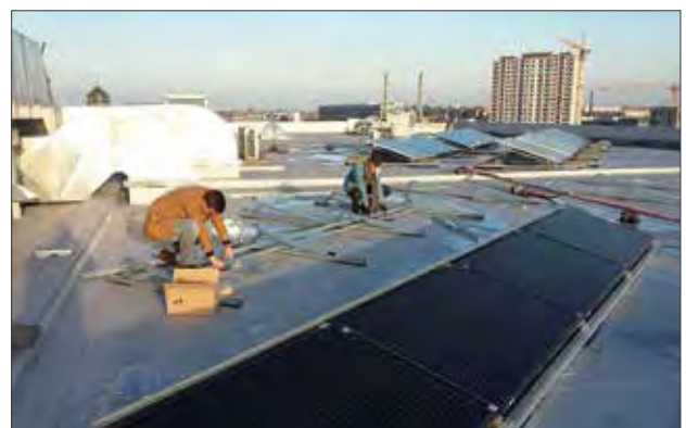
Installation der Solarpanels auf dem Dach
