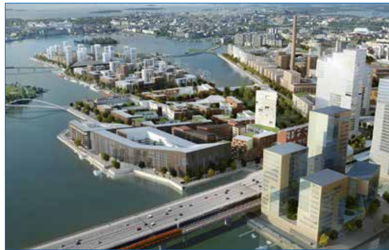
Kalasatama – Turm und Brücke von Kulosaari (Bildquelle: Suomen Ilmakuva Oy)
