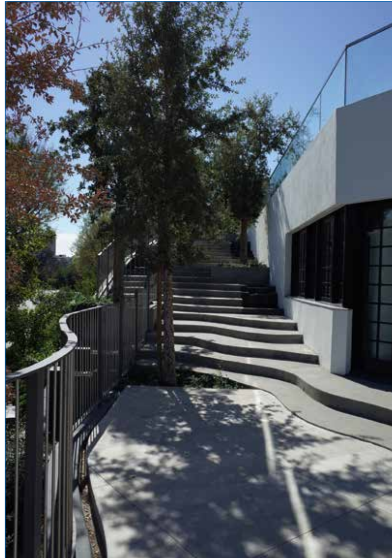
Moderne Architektur im Poolbereich. Die Jandy Pooltechnik ließ sich in die zentrale Kontrolle mit TV, PC und iPad integrieren.
