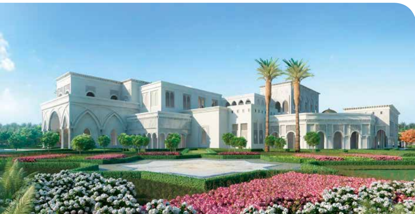
Die Rückseite des Palastes: Die KNX Automation steuert die repräsentative Fassaden- und Landschaftsbeleuchtung.
