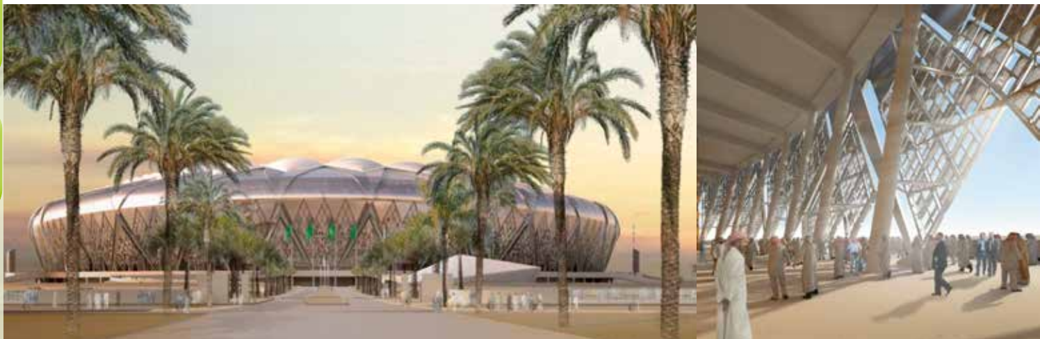
Juwel in der Wüste: Die Beleuchtung im zweitgrößten Stadion Saudi-Arabiens steuert KNX.
