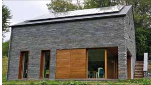
In diesem Ferienhaus in den belgischen Ardennen können sich interessierte Bauwillige von intelligenter Gebäudetechnik inspirieren lassen.
