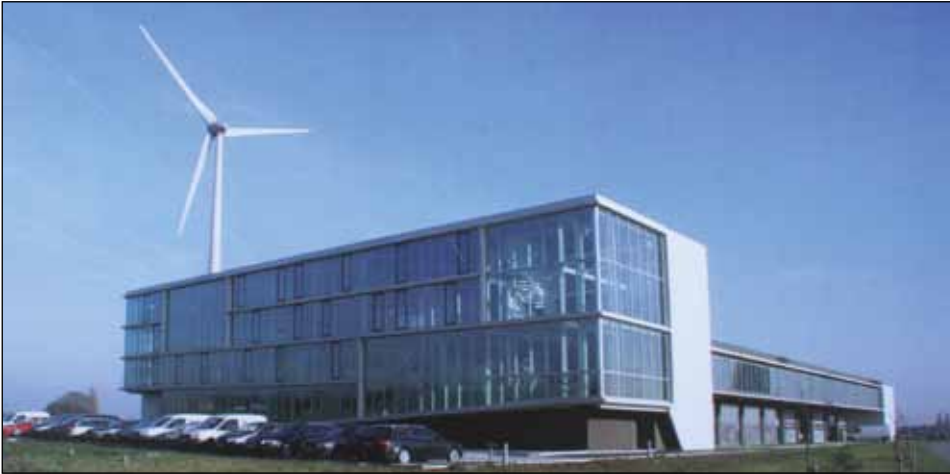
Hinter der modernen Architektur sorgt KNX für energieeffiziente Gebäudetechnik.
