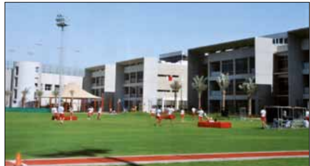
Schulalltag der American School of Dubai. Bei der Gebäudetechnik übernimmt KNX die „Regie“ und sorgt so für effiziente Energienutzung.
