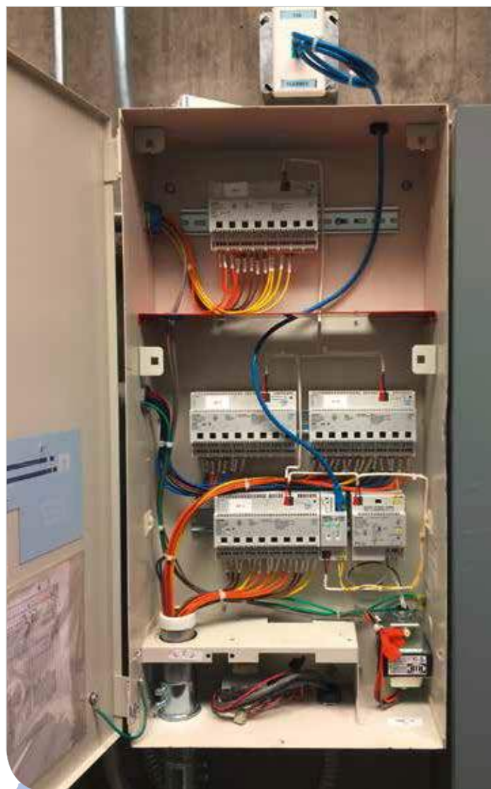
Das GAMMA System ermöglichte eine verteilte Steuerungsarchitektur, durch die alle Anforderungen an die Beleuchtungssteuerung des Stadions erfüllt werden konnten.
