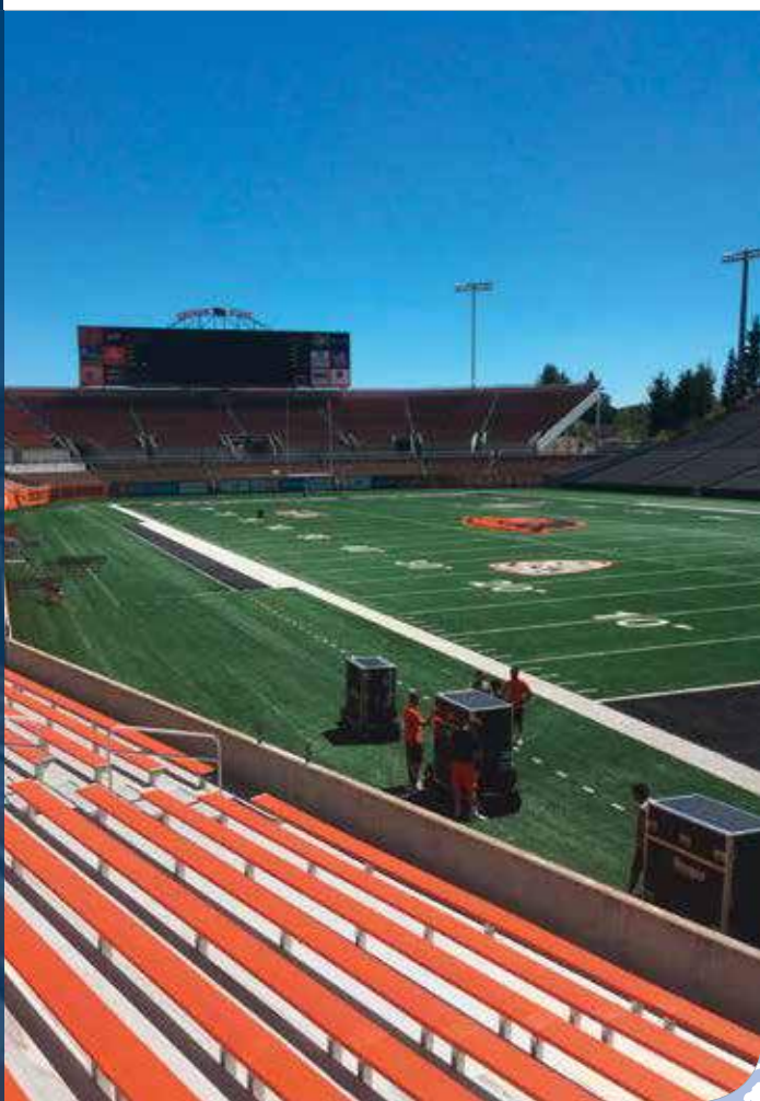
Das Reser Stadion rüstet die Beleuchtung mit der KNX Gamma Beleuchtungssteuerung nach.
