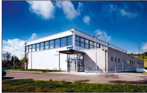
In dieser Sporthalle regelt und steuert KNX energierelevante Anlagen, analysiert Verbrauchsdaten und realisiert Sicherheitsfunktionen
