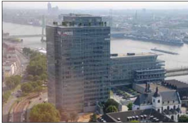
Im Lanxess Tower und in den dazu gehörenden Rheinetagen unterstützt KNX Automation die energetische Sanierung.
