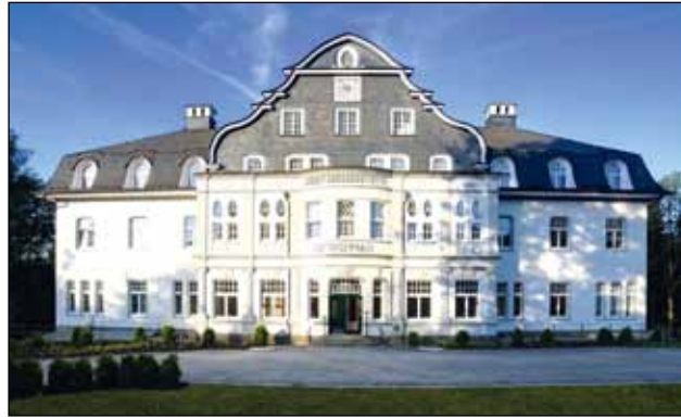
Behaglichkeit und Energieeffizienz – dank hoteltypischer KNX Lösungen
