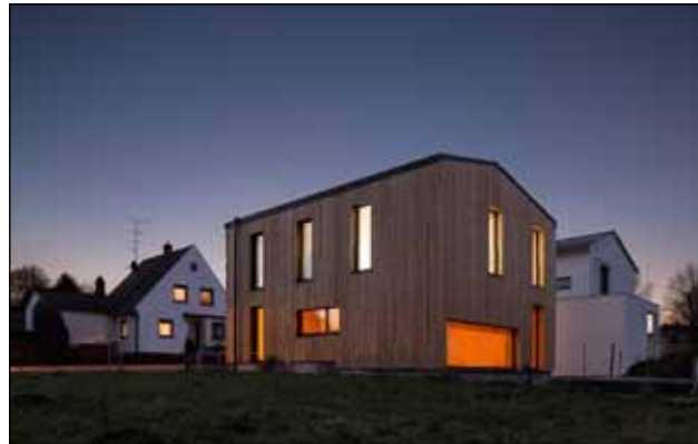
Schon der Eindruck von außen sagt: Das Haus hat es in sich – z. B. KNX Gebäudesystemtechnik für effiziente Energienutzung.
