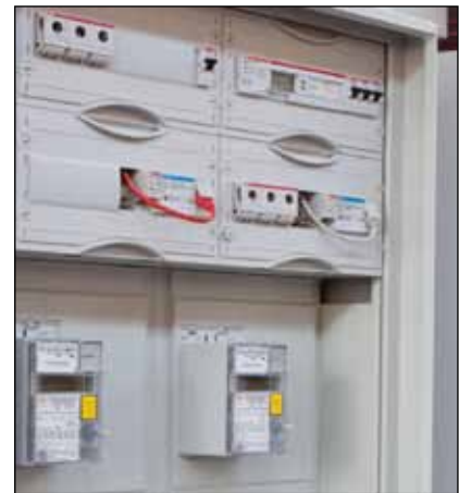
Intelligenter Haushaltszähler für Photovoltaik und verwandte Systeme inklusive KNX Submetering
