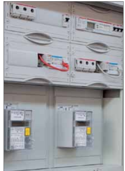
Ευφυής οικιακός μετρητής για τα φωτοβολταϊκά και τα συναφή συστήματα, συμπεριλαμβανομένων και των μετρήσεων KNX.
