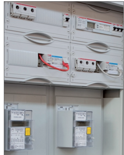
Compteur domestique intelligent pour les systèmes photovoltaïques et autres systèmes apparentés, incluant le comptage divisionnaire KNX.
