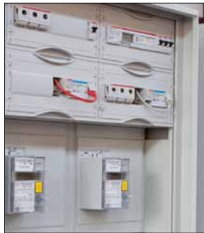
Intelligenter Haushaltszähler für Photovoltaik und verwandte Systeme inklusive KNX Submetering
