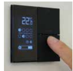
Eindgebruikers kunnen de setpoint met \pm 2^\circ\text{C} veranderen en de ventilatorsnelheid handmatig sturen.
