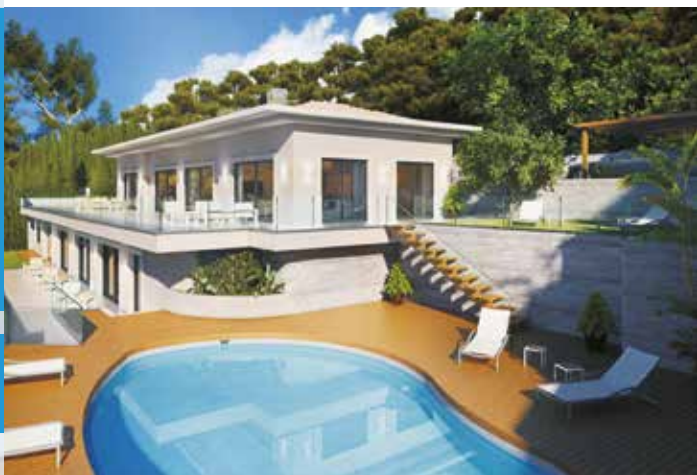
Eine private Villa in Eze (Südfrankreich): Steuerung der Heizungs-, Lüftungs- und Klimatechnik erfolgt über KNX, konfiguriert ausschließlich mittels ETS
