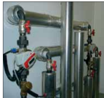
圖1. 暖氣量表附M-Bus介面和M-Bus-KNX開道
