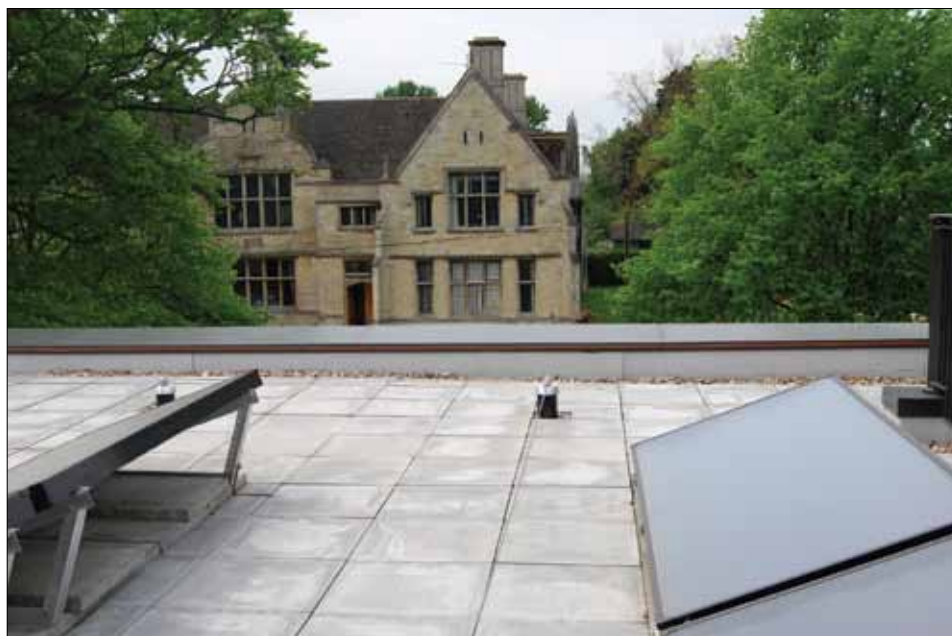
圖4. 永續資源：用以供應熱水的太陽能板。
