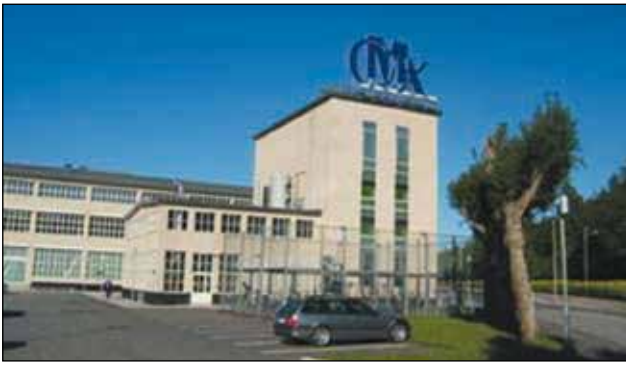
Figur 4. Stockholms Fondbörs kontorshuset skapades från en gammal Ford fabriksbyggnad. Källa: Energoretea
