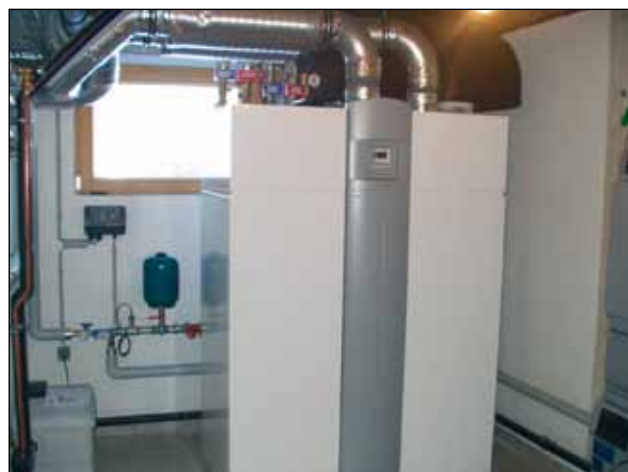
Figur 2. Integrationen av luft/vatten värmepumpar in i lokalen och att ventilation styrs via KNX är grunden för det låga energibehovet.
