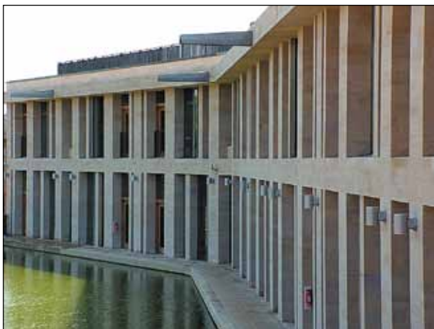
Figur 1. Oundle-skolens SciTec-senter som kombinerer vitenskap, kunst og teknologi, og som har blitt bygget ved hjelp av fremtidsrettet, bærekraftig teknologi, som for eksempel KNX. Kilde: Andromeda
