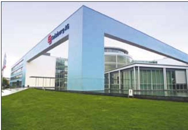
Figur 4. Hovedkontoret i Salzburg AG, der KNX-kontrollsystemet for byens gatebelysning har blitt gjennomført.
