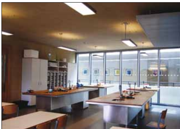
Figur 2. Energieffektivitet 1: Konstant lysregulering med KNX i laboratorier Kilde: Andromeda
