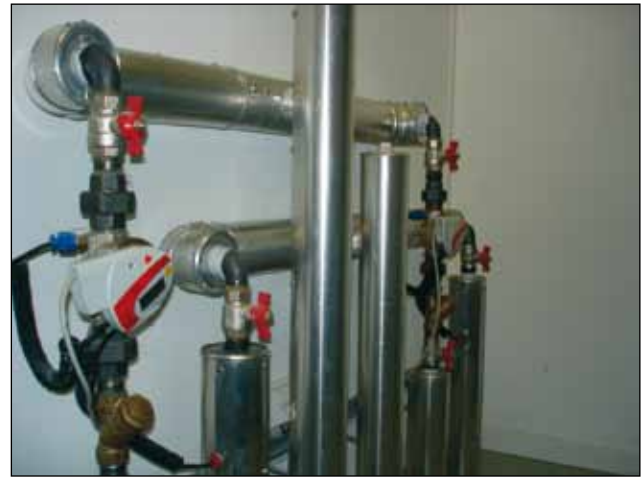
Figur 1. Varmemåling med grensesnitt for M-buss og M-buss-KNX port
