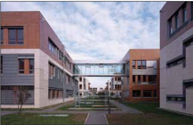
In de lichtinstallaties tussen de gebouwcomplexen, een duidelijk potentieel voor energiebesparing met KNX. Foto: Infineon/Heinemann
