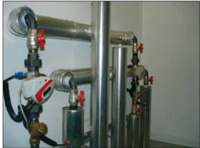
Afbeelding 1. Warmtemeters met M-Bus interface en m-Bus/KNX-Gateway.
