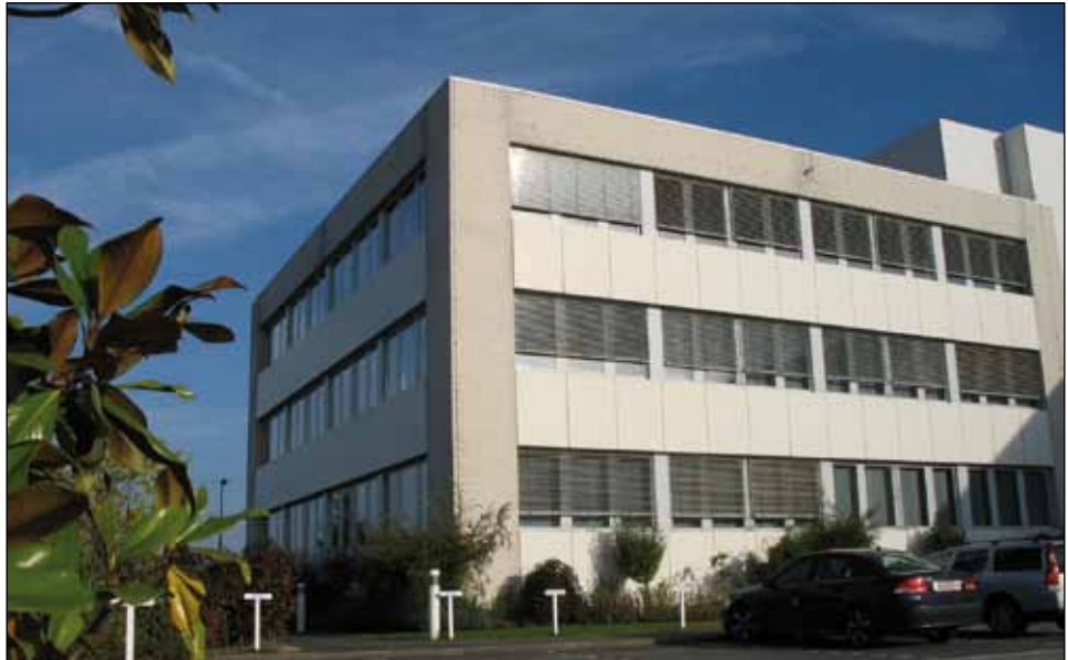
Een sensor-gestuurde zonwering reduceert de koellast
