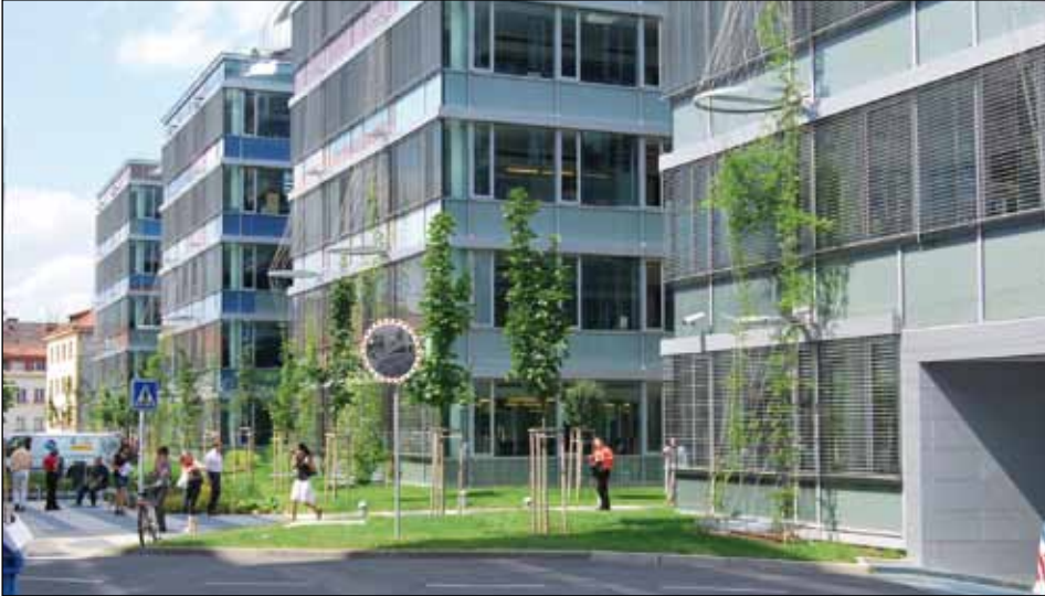
De zonwering bediend met KNX verbetert de energiebalans aanzienlijk
