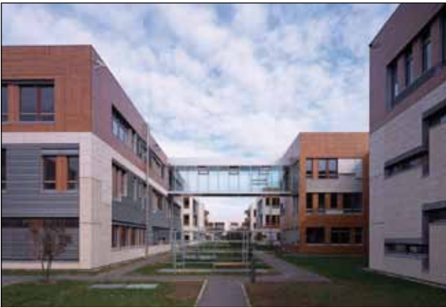
Nell'impianto di illuminazione tra due complessi di edifici, si può ottenere un significativo risparmio energetico tramite KNX. Foto: Infineon/Heinemann
