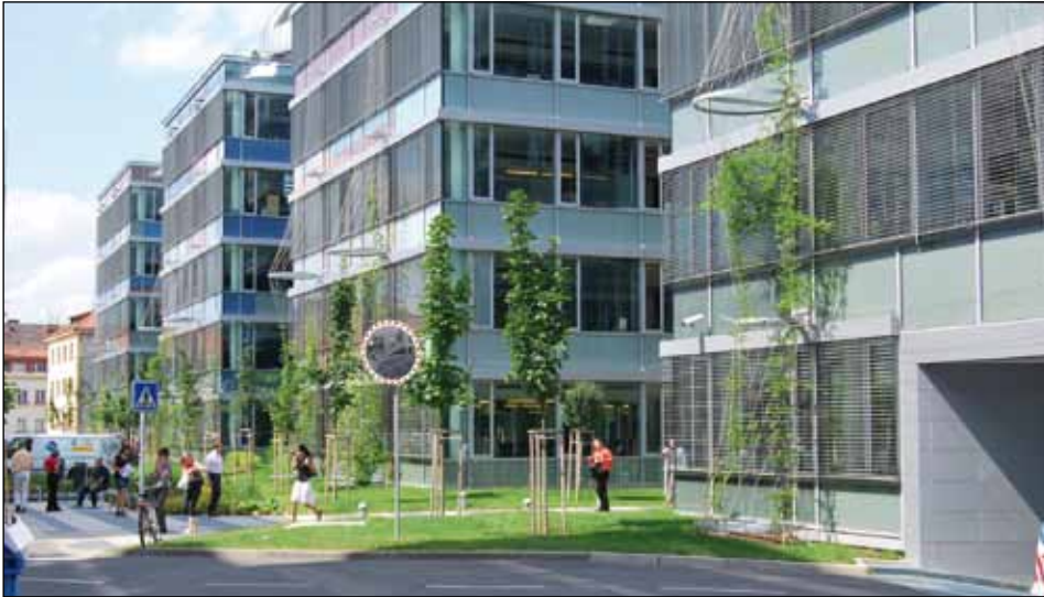
I sistemi di protezione solare controllate con KNX aiutano a migliorare notevolmente il bilancio energetico.
