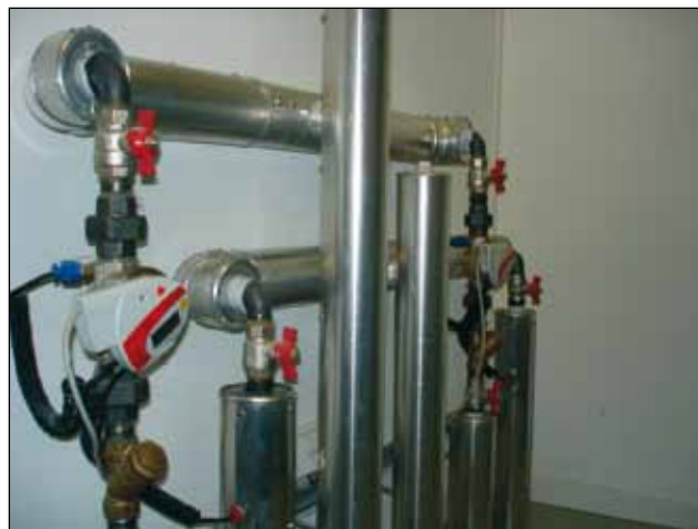
Figure 1. Contatori di calore con l'interfaccia M-Bus e M-Bus-KNX-Gateway
