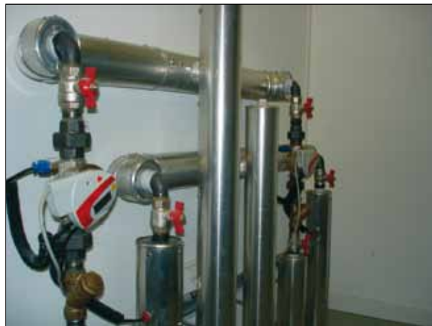
KÉP 1. Hőmennyiségmérő Mbus interfésszel és Mbus/KNX gateway-el
