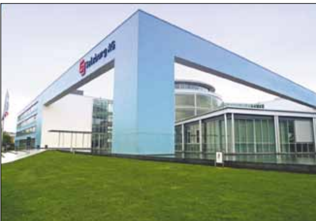
4. ábra. A Salzburg AG székhelye, ahol a KNX utcavilágítási vezérlést megvalósították Forrás: Schäcke
