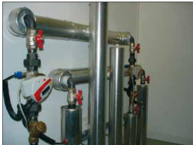
Slika 1. Kalorimetri sa M-Bussučeljem i M-Bus-KNX-pristupnik
