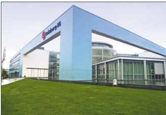
Slika 4. Sjedište Salzburg AG-a, gdje je implementiran KNX kontrolni sistem. Izvor: Shäcke
