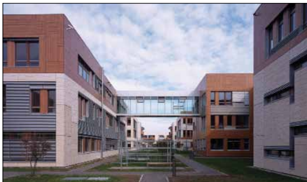
Dans les installations d'éclairage entre les complexes de bâtiments, un évident potentiel d'épargne énergétique peut être accessible avec KNX.
