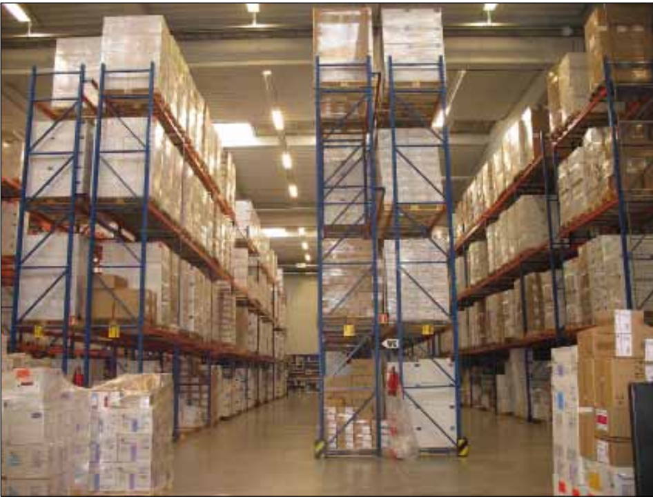
Réduction de la consommation actuelle dans l'entrepôt grâce à un contrôle automatique de l'éclairage
