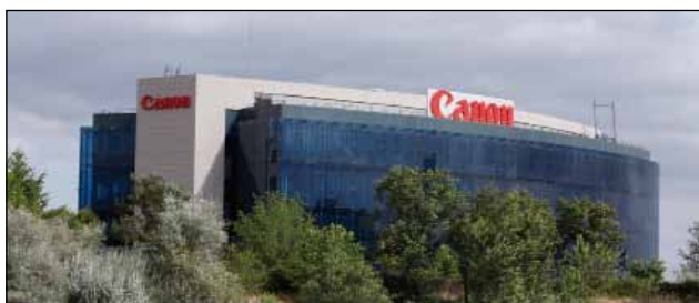
L'architecture courbe du nouveau siège Canon en Espagne est économe en énergie
