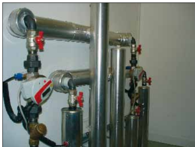
Figure 1. Compteur de chauffage avec interface M-Bus et M-Bus-KNX-Gateway
