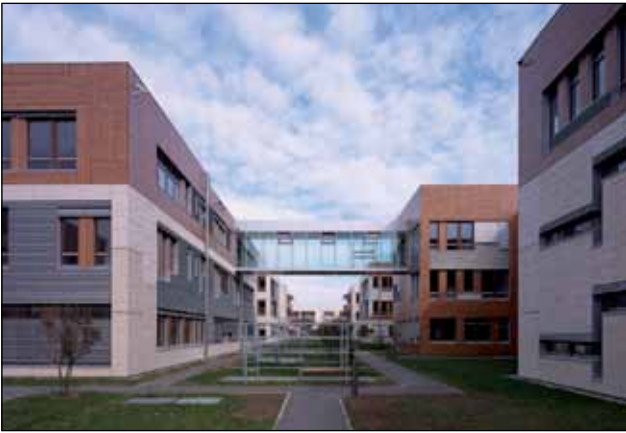
In den Beleuchtungsanlagen zwischen den Gebäudekomplexen ließ sich mit KNX ein deutliches Energie-Einsparpotential erschließen. Foto: Infineon/Heinemann
