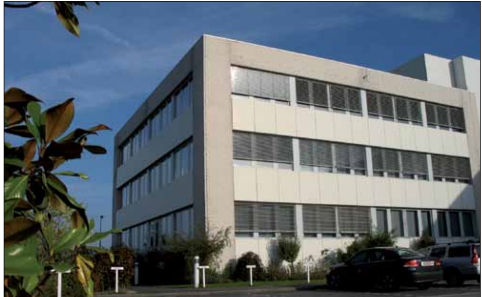
Ein sensorgesteuerter Sonnenschutz reduziert die Kühllast
