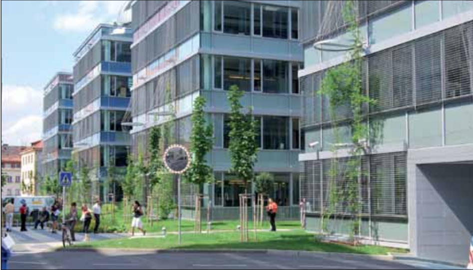
Die mit KNX gesteuerten Sonnenschutzanlagen helfen erheblich die Energiebilanz zu verbessern.
