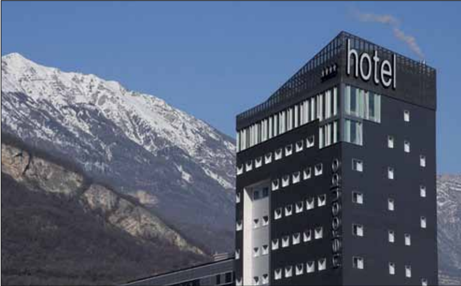
KNX-Funktionen sorgen hier für effiziente Energienutzung
