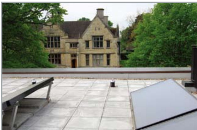
图4. 可持续资源: 提供热水供应服务的太阳能板 资料来源: Andromeda
