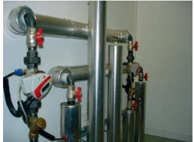
图1. 带有M-Bus界面和M-Bus-KNX-Gateway的热量仪表
