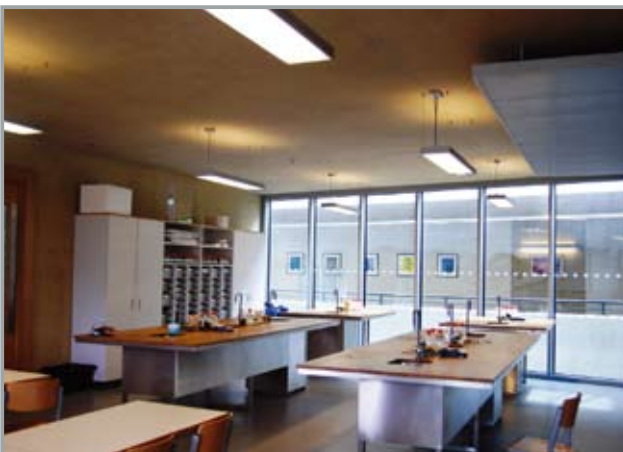
图2. 能源效率1: 实验室通过KNX进行恒定亮度调节 资料来源：Andromeda
