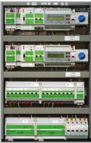
图3. 顶层测量室中的KNX组件 来源: Schäckle
